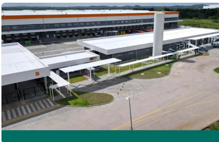
Galpão G3 - Cone Multimodal Cabo de Santo Agostinho, PE
